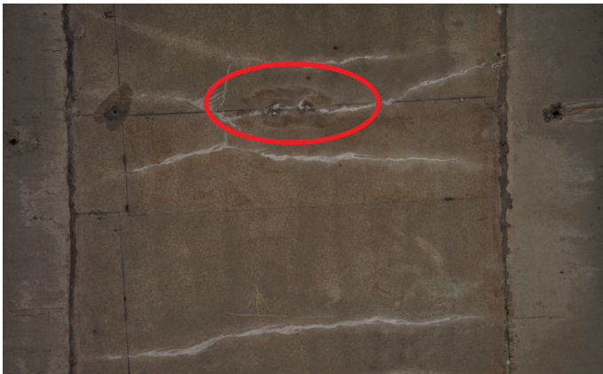
Fassaden + Brücken (Beton)
